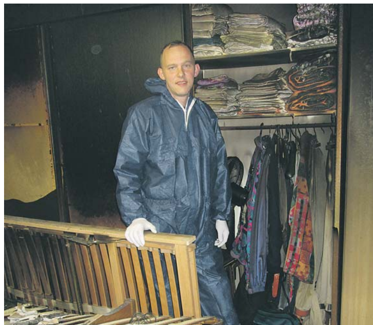
Reinigungsarbeiten nach einem Wohnungsbrand, Geruchselementierung eingeschlossen.
